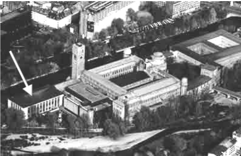
Bild 6: Die ehemalige „Eisenbahnhalle“ des Deutschen Museums (Pfeil) wird für das „Zentrum Neue Technologien“ (ZNT) umgebaut. Ein eigener Eingang zur Corneliusbrücke (außerhalb des linken Bildrandes) wird die Südseite der Insel mit ihren Grünflächen an der Isar zur Stadt hin öffnen und einen direkten Zugang zu Sonderausstellungen und Abendveranstaltungen ermöglichen ( http://www.deutsches-museum.de ).
