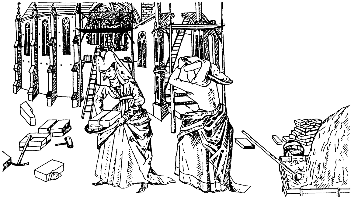
Bild 77: Frauenarbeit auf einer Kirchenbaustelle. Auf dem Bild finden sich alle Accessoires einer zünftigen Baustelle: Fäustel, Spitzfläche, Gerüst, Leiter, Mörtelbottich, Mörtelkasten, Mörtelschaufel, Ziegel und behauene Steine, Mulde, Schulterstock und Wasserbottich sowie die Arbeiterinnen. Buchmalerei aus der Girart-de-Roussillon-Handschrift 1447/50 (Binding 2001, 192)
