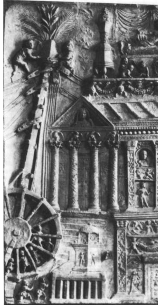
Bild 44: Römischer Baukran mit einem von mehreren Menschen - aller Wahrscheinlichkeit nach Sklaven - getriebenen Tretrad. Relief vom Grabmal der HATERII in Rom, 1. Jbt. n. Chr. (Eggebrecht 1980, 113)
