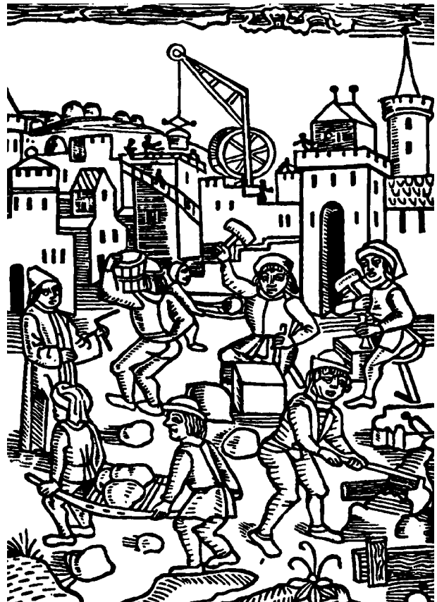
Bild 65: Bauhandwerker beim Stadtausbau. Holzschnitt aus der Koebloffschen Chronik von Köln 1499 (Kottmann 1980, 5)
