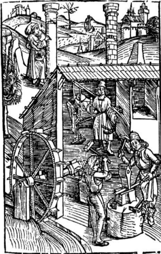
Bild 62: Schmiede vor den Toren der Stadt: Ein Wasserrad mit Daumenwelle treibt den Schwanzhammer zum Schmieden. Holzschnitt 1488 (Klemm 1989, 53)
