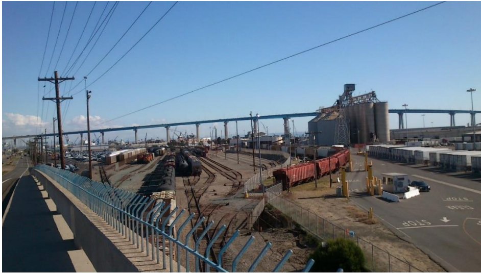
Abb. 10: Blick auf den Hafenbereich und die Coronado Bridge in Barrio Logan (Quelle: L.W.)
