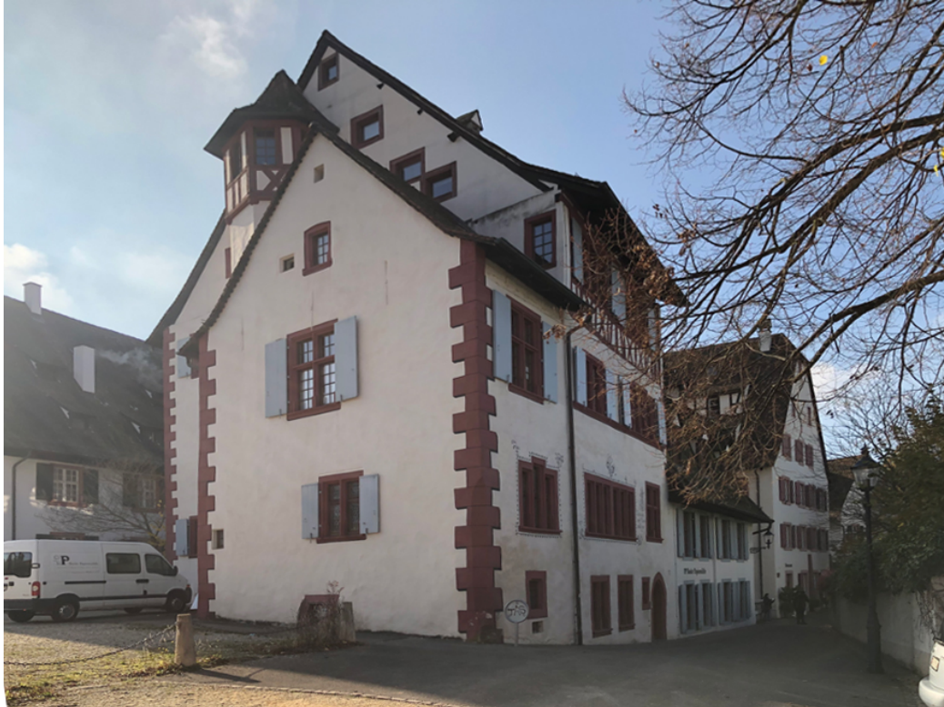
Abbildung A-24: Sanierter Zustand Gallicianmühle und der Stegreifmühle, ab 1975 [PHOTOGRAPHIE MICHAEL VON ALLMEN, 2022]
