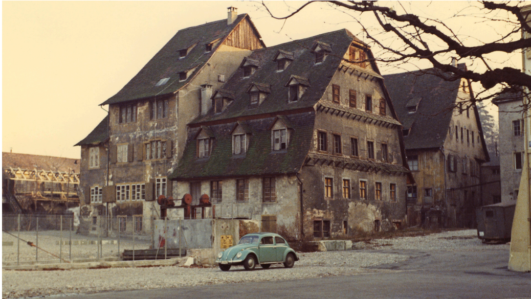
Abbildung A-23: Zustand der Gallicianmühle (Vordergrund) und der Stegreifmühle (Hintergrund), um 1960 [WWW.DALBEDYCH.CH, 2023]
